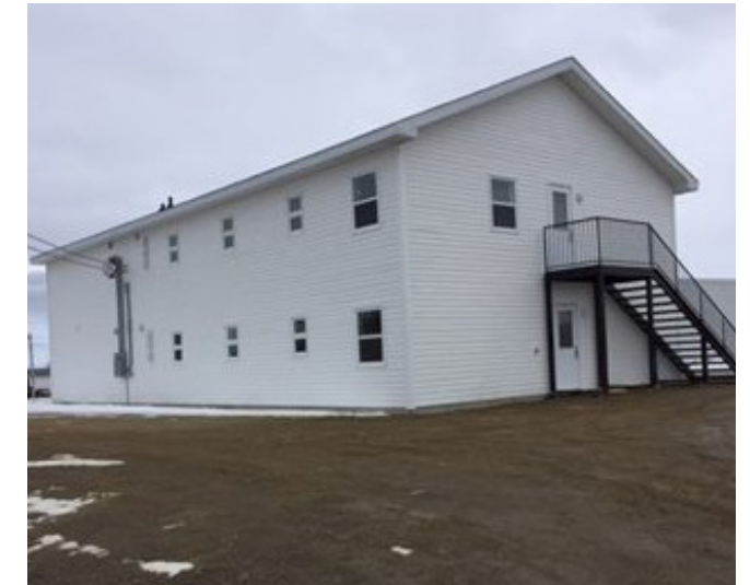
Baie Chaleurs Bunkhouse. Photo Credit: Baie Chaleurs
